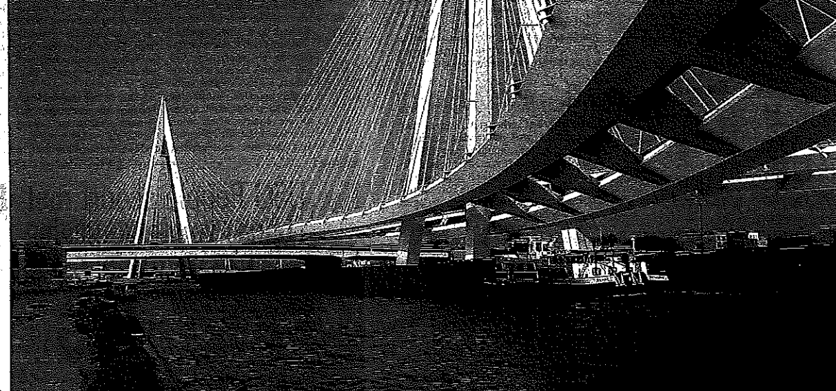
De enkeldeksbrug van THV Antwerpse Bouwwerken: het goedkoopste en meest logische brugalternatief dat sneuvelde in één kafaïaanse procedure. © rr
